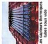
Les capteurs thermiques tubes sous vide
